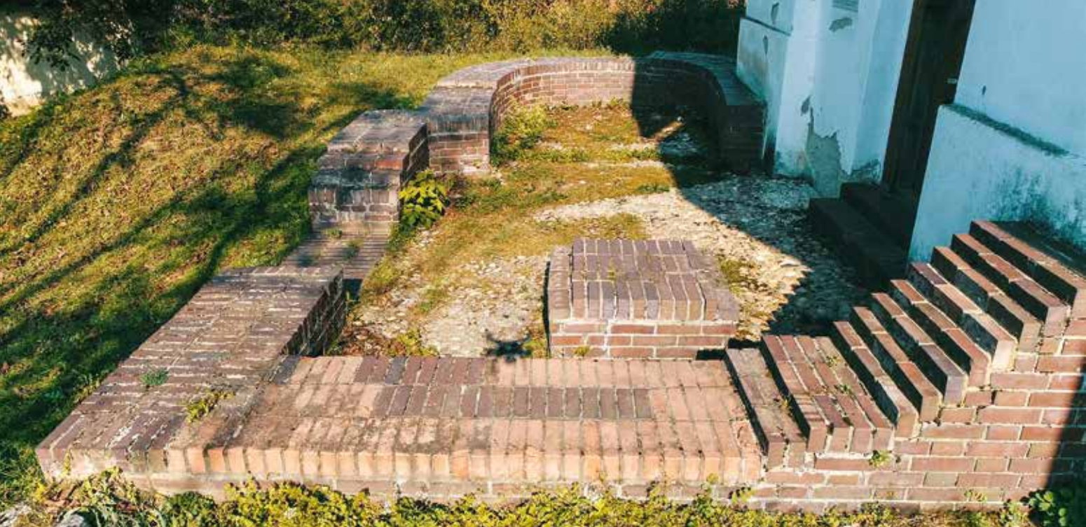
10. KÉP. A lebontott téglatemplom felmenő falainak helyreállított indítása. Mészáros Magor drónos felvétele.
